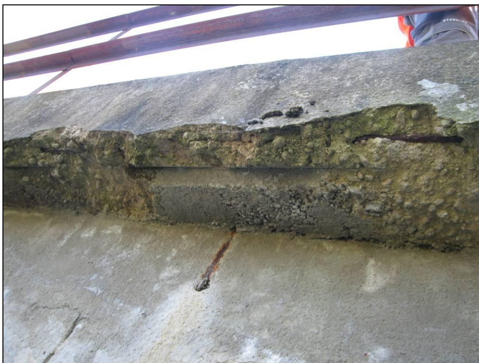
Obr. č. 10 - Pohled na porušený beton římsy - opady betonu do hl. až 4 cm a pokračující koroze betonu (cca 20 % plochy).
