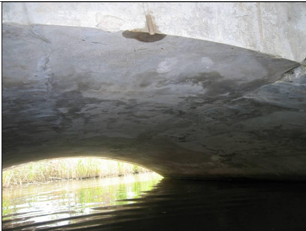
Obr. č. 7 - pohled na NK zprava - beton je na povrchu opatřen cementovou omítkou, v líci je pevný a na poklep zdravý.
