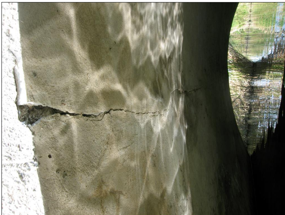
Obr. č. 8 - pohled na průběžnou trhlinu na spodním líci NK, kolmou na osu trati
